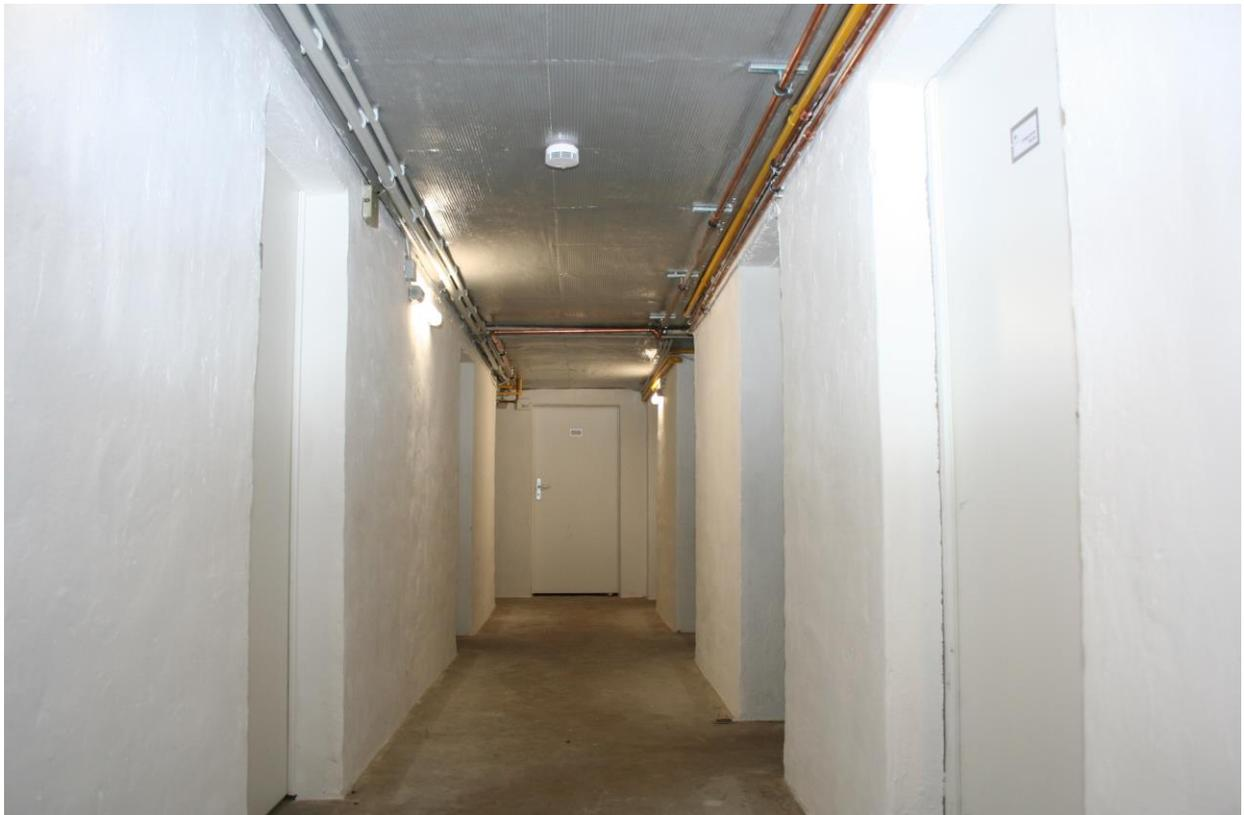
Beleuchteter Kellergang mit Kellerdeckendämmung und darunter verbauten Gas-/Strom-/Wasserleitungen
