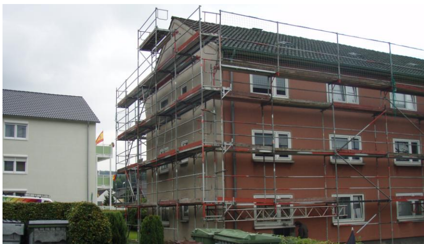
Im Bild: Das eingerüstete Gebäude Kampgarten 13, im linken Hintergrund das bereits fertiggestellte Gebäude Kampgarten 11. Foto: iwB 25.06.2012
